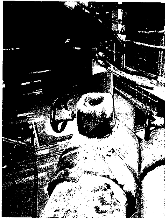
แสดง Butterfly valve and Balancing Valve เป็นสนิม
